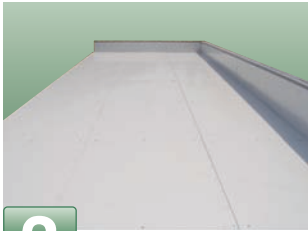
3 NBCボード取付け完了
