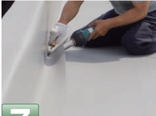
7 立上りシート貼り
