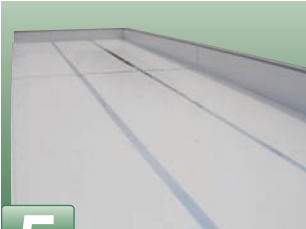
5 防水下地完成
